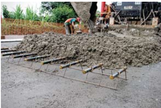
Colocación de Dowel en pavimento
