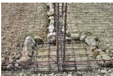
Plintos o zapatas y contrapisos en viviendas.
