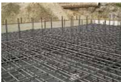
Losas de cimentaciones.
