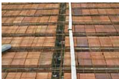
Losas, losetas, cascarones de cubierta.
