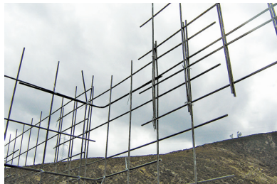
Refuerzo angular de muros portantes.
